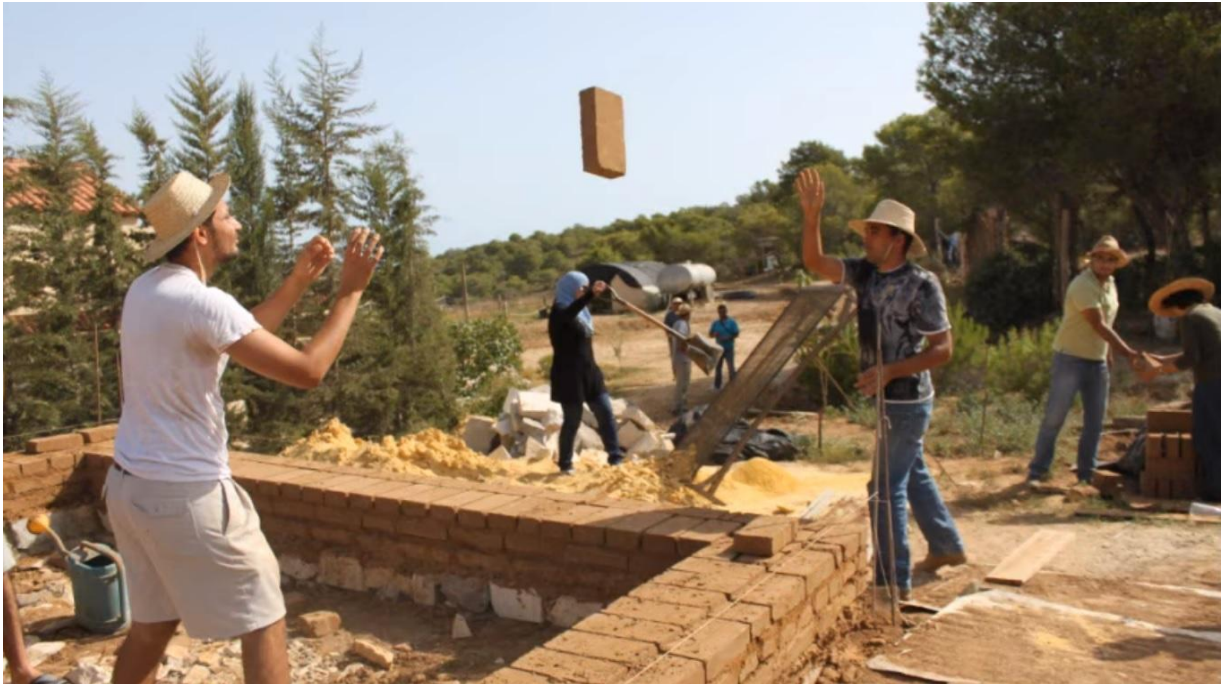
Utilisation de BTS dans un chantier de Sidi Amor, Tunisie, 2011, photographe Lamine Maaoui
